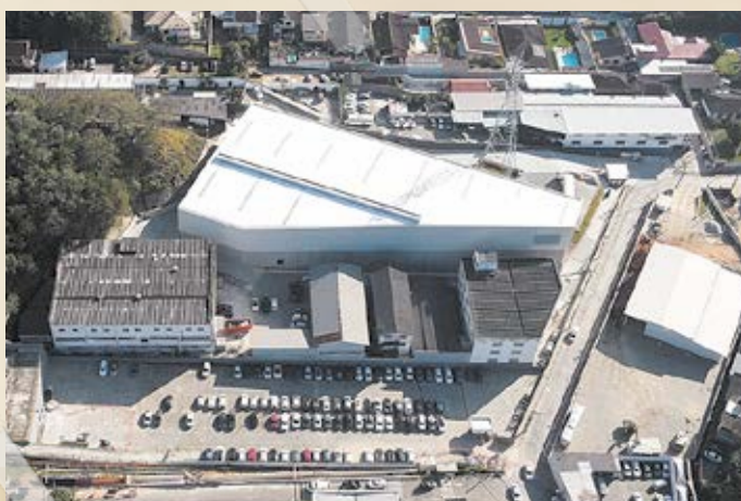
No antigo prédio da Dentsply foi montado o novo Centro Administrativo e Centro de Distribuição.
